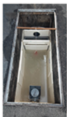
ブロック投入中
